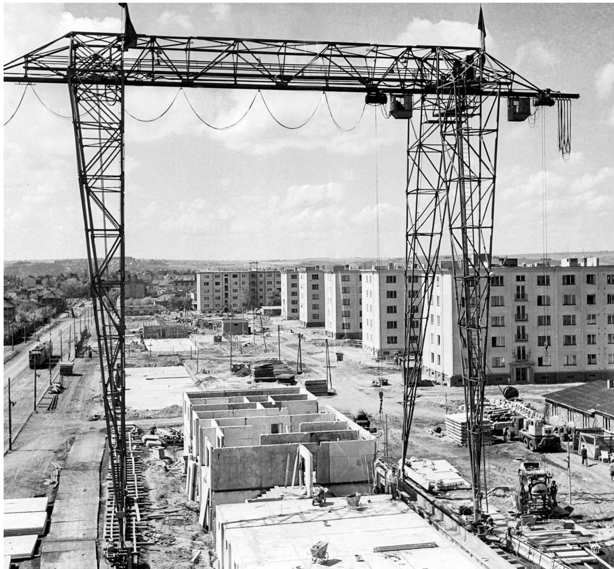
vlevo ulice Antala Staška, výstavba panelového sídliště
