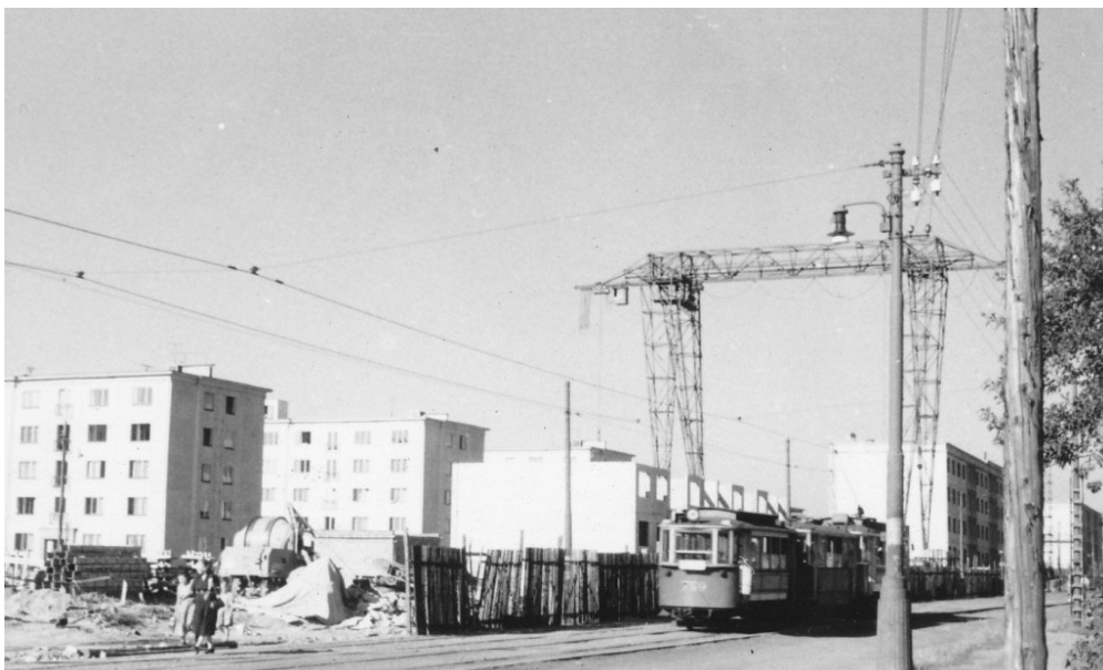
Ulice Antala Staška, výstavba panelového sídliště
