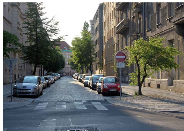
075 Jednosměrná zklidněná ulice s obousměrným provozem jízdních kol, charakter dotváří stromořadí a volba přírodních materiálů [ Praha 6, Dr. Zikmunda Wintra ]
