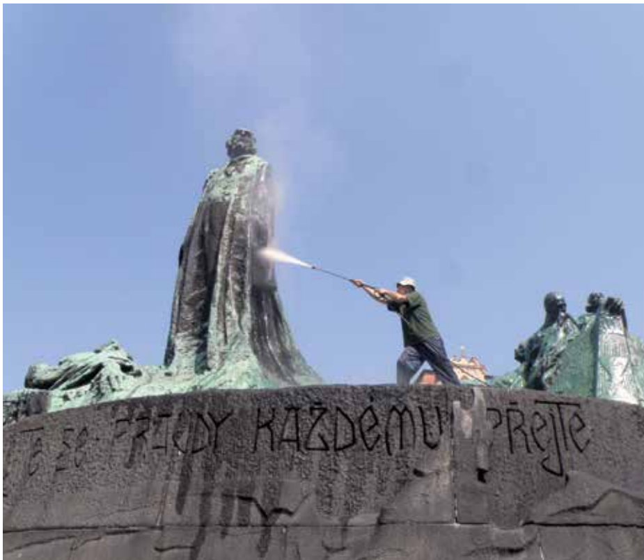
Restaurátorství obnáší i práci ve výškách. Foto: archiv AŠ
