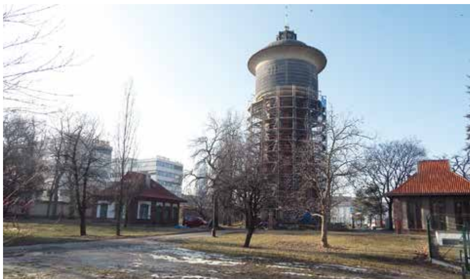
Okolí Vršovické vodárny by se mělo přeměnit ve veřejný park.
