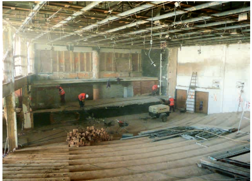
NEJVÝZNAMNĚJŠÍ ČÁSTÍ současných bouracích prací je odstranění celého hlediště bývalého kina.
