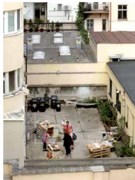
Zanedbaný vnitroblok se může přeměnit v oázu klidu.
