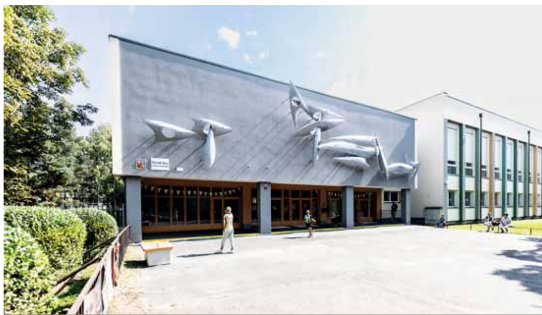
Plastika na fasádě ZŠ Filosofská prošla opravou a opět zdobí plochu nad školním vchodem.
