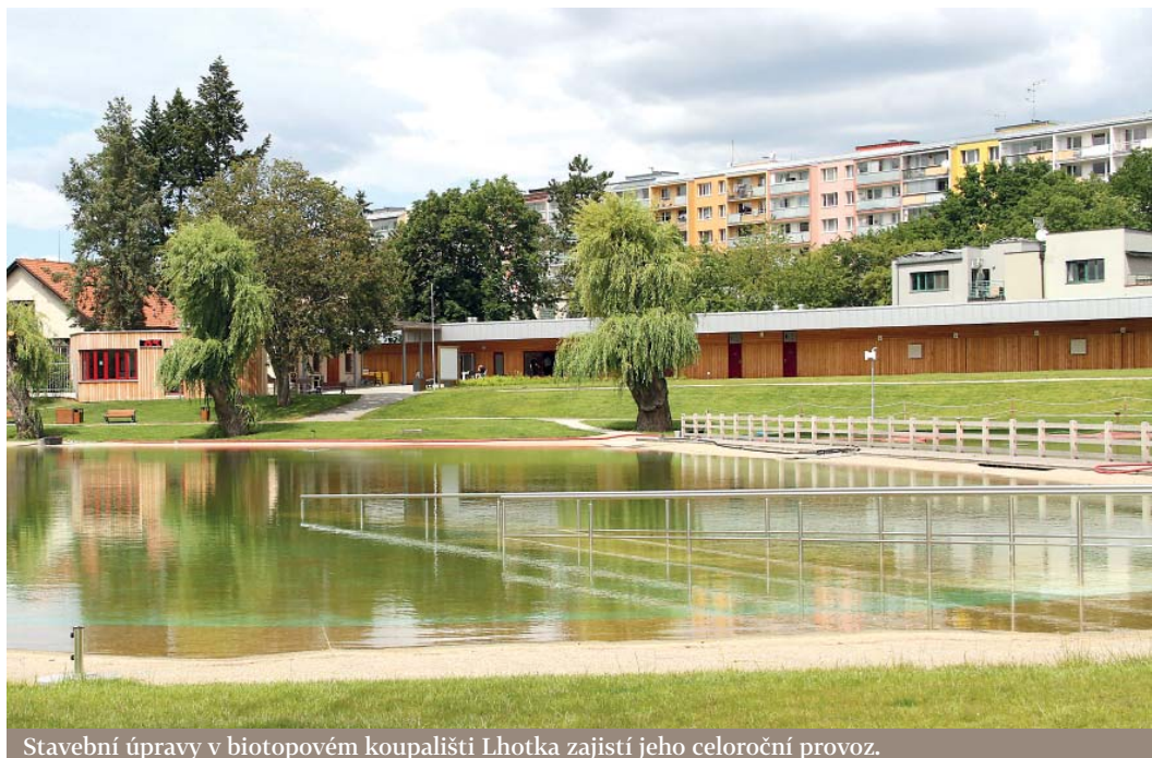
Stavební úpravy v biotopovém koupališti Lhotka zajistí jeho celoroční provoz.
