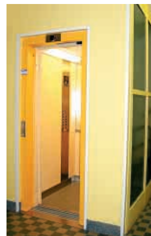
Gen2 NOVA – modernizace výtahu
