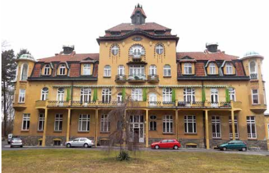
Dnes je toto zařízení součástí krčské nemocnice a nese název Dětské centrum při Thomayerově nemocnici. MČ Praha 4 pro něho pořádá každoroční humanitární sbírku. Foto: Martin Dudek
