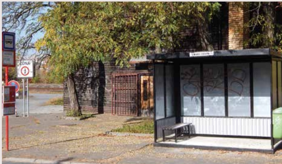
Repasovaný autobusový přístřešek na zastávce Nad Havlem.
