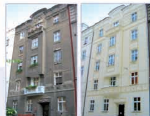
PŘED REKONSTRUKCÍ / PO REKONSTRUKCÍ
