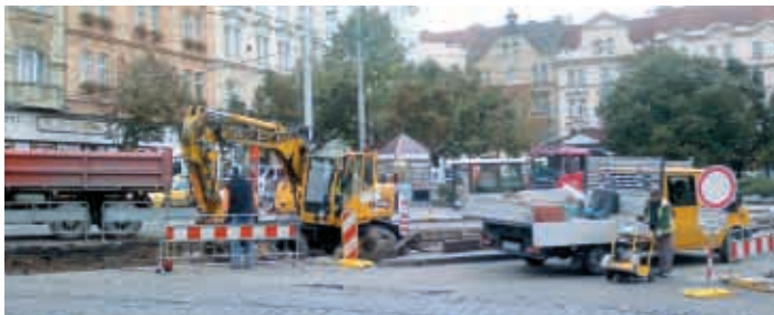
Na Náměstí Bratří Synků nahradil hlomoz stavebních strojů cinkot tramvajů. Foto: Martin Dudek
