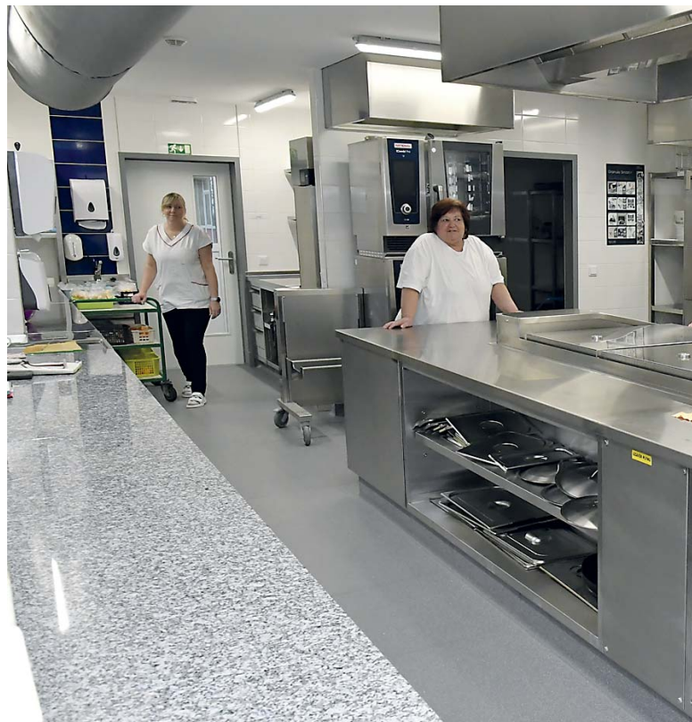
Rekonstruovaná kuchyně v Mateřské škole Sdružení v Nuslích. V investičním roce.
