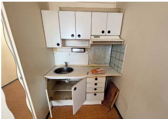
Pohled na kuchyňský kout před opravou a po ní. Foto:4-M
