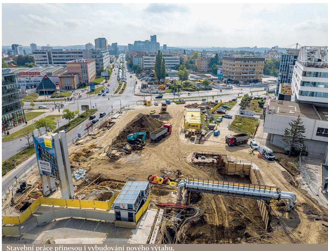
Stavební práce přinesou i vybudování nového výtahu.
